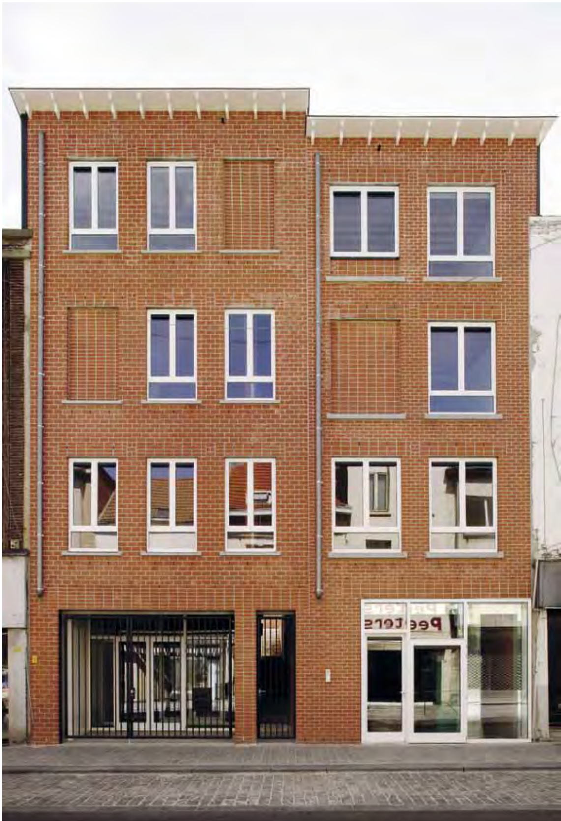
Woningen Driekoningenstraat, Antwerpen, architecten de vylder vinck taillieu © Filip Dujardin
