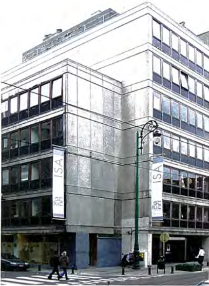
Institut Supérieur d'Architecture Saint-Luc Brussel, architect Emile Verhaegen, 1965
